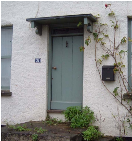
13 Solid timber plank door
